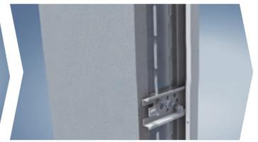
Alle Trapezanker mit Schrauben am UA-Profil befestigen. Nach Erfordernis unterfüttern
